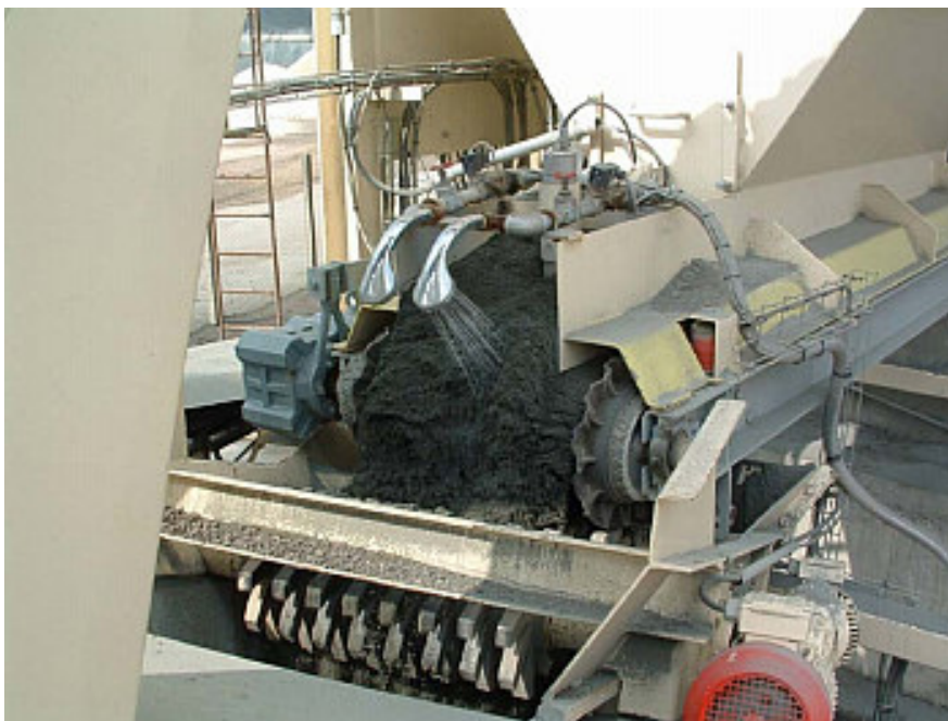
Fot. 18 – Dodatkowe zwiększanie wilgotności kruszywa frakcji piaskowej poprzez skropienie wodą [12]
