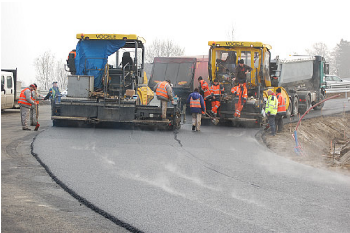
Fot. 26 – Rozkładanie mieszanki SMA wyprodukowanej ze środkiem Ceca Base RT równocześnie przez dwie rozkładarki
