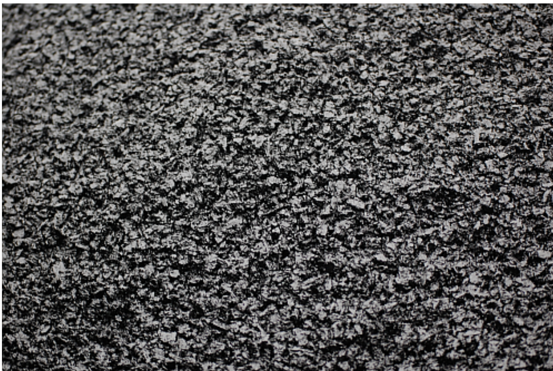
Fot. 25 – Widok mieszanki SMA wyprodukowanej ze środkiem Ceca Base RT po załadunku do skrzyni samochodu ciężarowego
