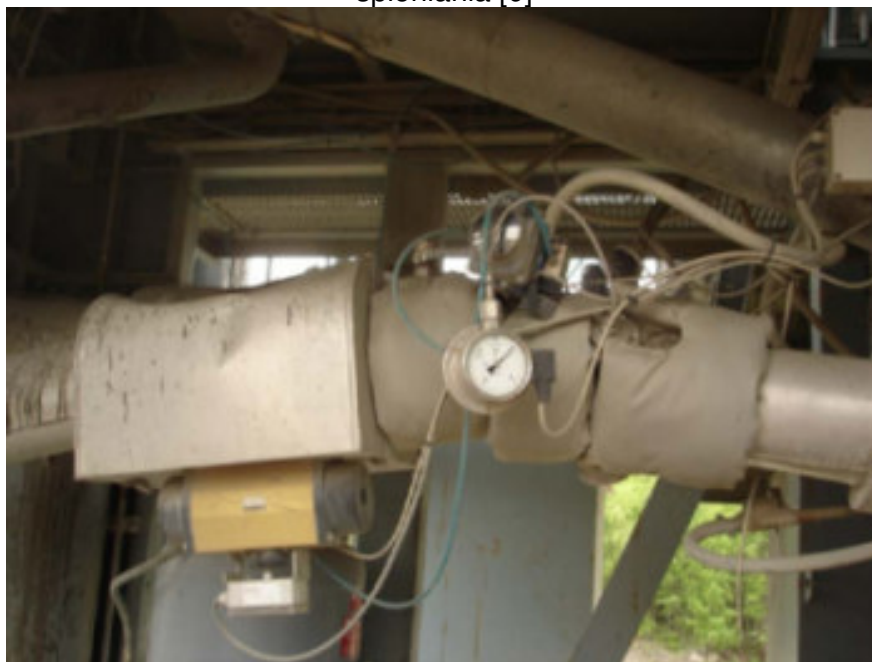
Fot. 14 – Komora spienienia w powiększeniu [12]
