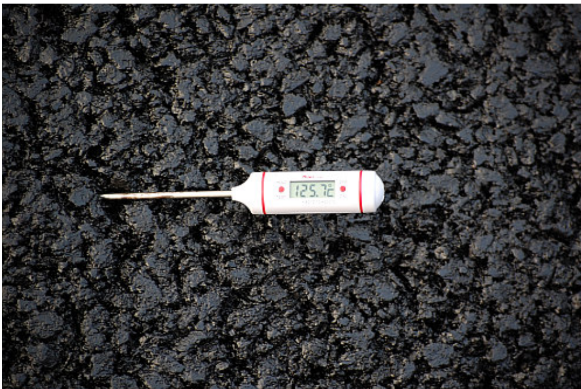
Fot. 28 – Jeden z pomiarów temperatury mieszanki w trakcie układania
