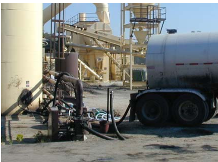
Fot. 17 – Cysterna z emulsją Evotherm ET podłączona do instalacji pompowania asfaltu WMB [15]
