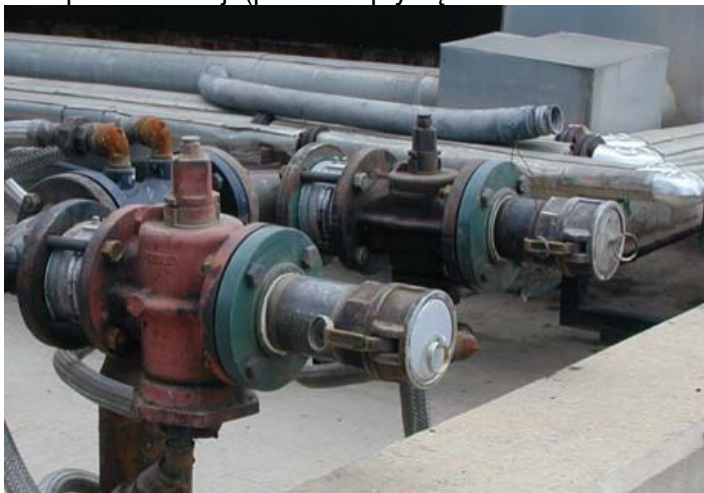
Fot. 16 – Zawory służące do przyłączenia cysterny z Evothermem ET [15]
