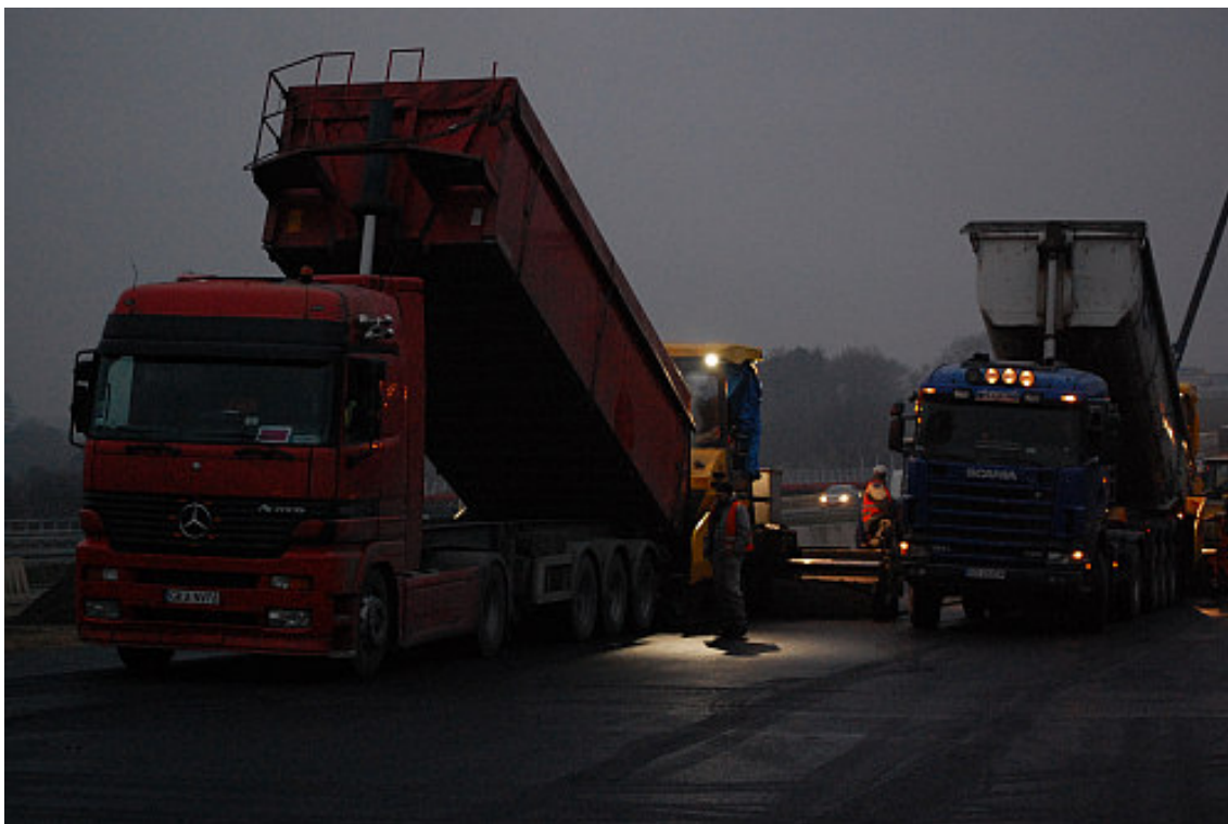
Fot. 29 – Rozkładanie mieszanki SMA wyprodukowanej ze środkiem ViaTop Plus CT 40 równocześnie przez dwie rozkładarki
